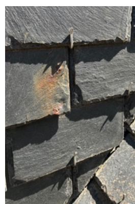
Mosvorming en vervuiling van de leien dakbedekking. Plaatselijk uitgeschoven, gebroken leien en aanwezigheid van piriet
