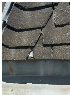
Mosvorming en vervuiling van de leien dakbedekking. Plaatselijk uitgeschoven, gebroken leien en aanwezigheid van piriet
