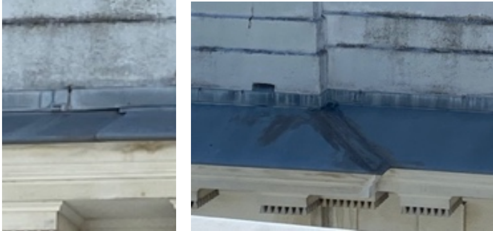
Openstaande en slordig afgewerkte naden van de zinken afdekking van de kroonlijst
