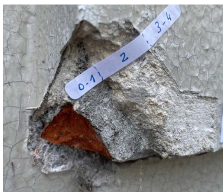
Vrijlegging van de recente strengperssteen in de zijgevel in de Koolstraat. © Fenikx, 2025
