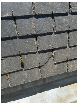
Mosvorming en vervuiling van de leien dakbedekking. Plaatselijk uitgeschoven, gebroken leien en aanwezigheid van piriet
