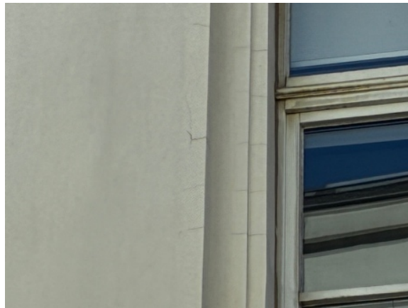
Haarscheurtjes op de hoeken van de pilasters tussen de ramen
