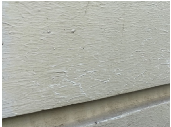
Slordig aangebrachte verflaag en gecraqueleerd oppervlak.
