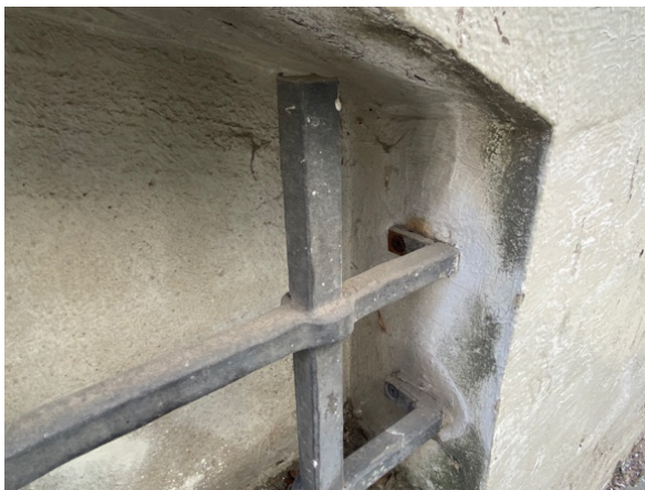
Roestvorming en vervuiling van diefijzers.
