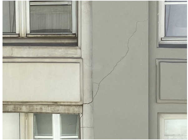
Barsten aan de rechterzijde van de gevel die ook doorlopen in de recente afwerking van buur Anjelierenstraat 3.
