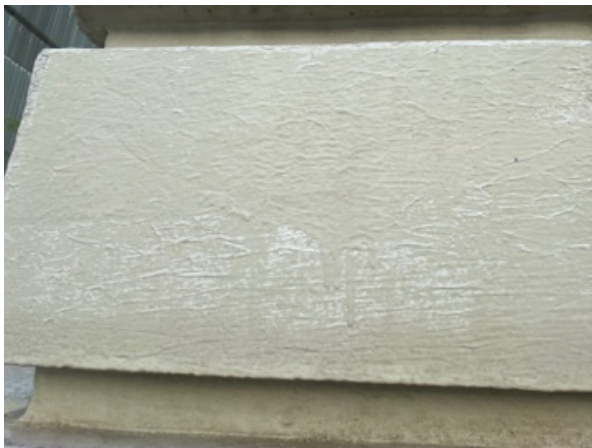
Slordig aangebrachte verflaag en gecraqueleerd oppervlak.
