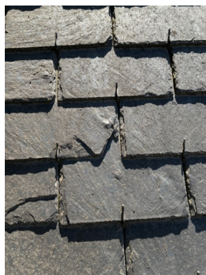
Mosvorming en vervuiling van de leien dakbedekking. Plaatselijk uitgeschoven, gebroken leien en aanwezigheid van piriet
