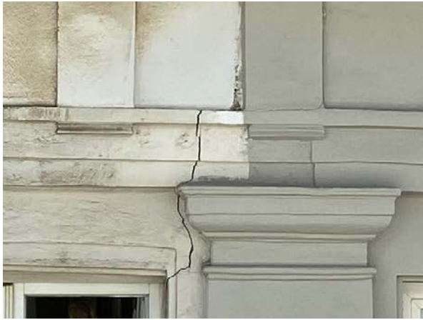
Barsten aan de rechterzijde van de gevel die ook doorlopen in de recente afwerking van buur Anjelierenstraat 3.
