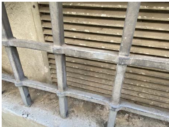
Roestvorming en vervuiling van diefijzers.
