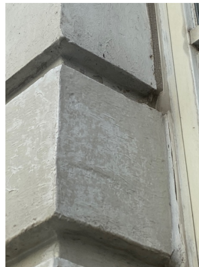
Kleurverschil met anti-graffiti-verf onderaan de gevel en plaatselijk schraal worden van deze laag.
